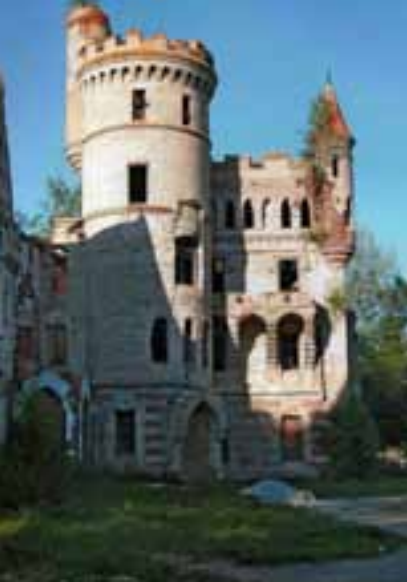
Илл. 15 – Состояние усадьбы полковника лейб-гвардии В. Храповицкого в пос. Муромцево. Владимирская область. Фото 2009 г.
